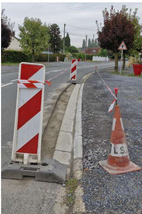
Travaux de chaussée : 11280 €
