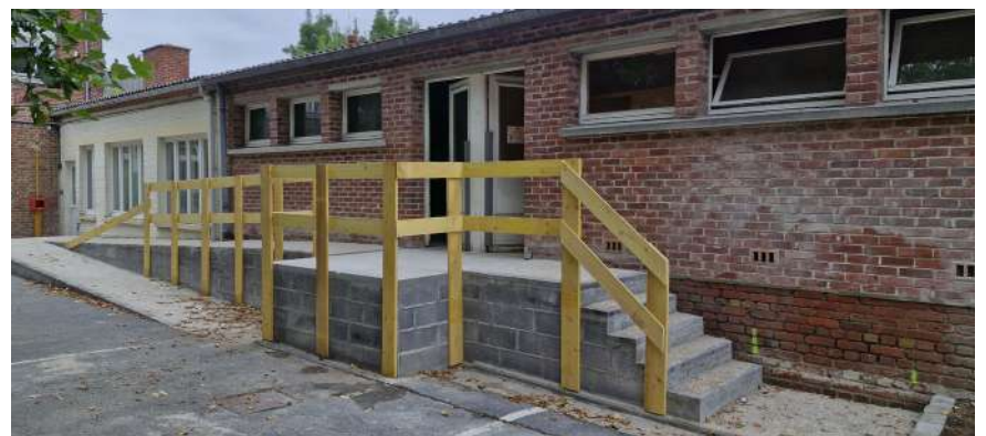
Installation d'une rampe PMR aux sanitaires de l'école Jules Ferry : 21396,55€
